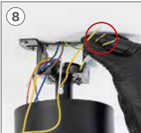
Conecte el cable de la toma de tierra de la pieza **K** al del motor. Además, si su instalación eléctrica consta de cable de toma de tierra propio, conéctelo también a los cables de la pieza **K** y el motor.
