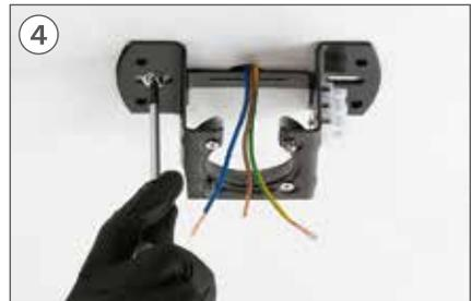
Coloque la pieza K y atornille los tornillos de fijación al falso techo.
