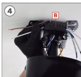
Conecte el cable FASE (L) de su instalación al cable FASE de la pieza **B**.
