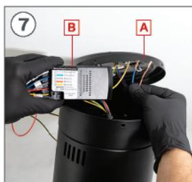
Conecte los cables de fase y neutro a la pieza **B**.
