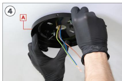
4 Coloque la pieza A haciendo coincidir sus agujeros con los tornillos E. Asegúrese de que los cables del techo pasan por el agujero central de la pieza A.
