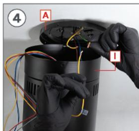
Conecte el cable de la toma de tierra de la pieza **A** al de la pieza **I**. Además, si su instalación eléctrica consta de cable de toma de tierra propio, conéctelo a los de la pieza **A** y la pieza **I** anteriores.
