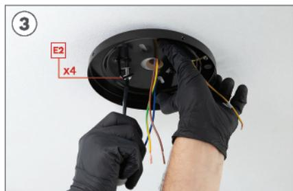
3 Coloque la arandela y posteriormente el tornillo E2 con la ayuda del destornillador.
