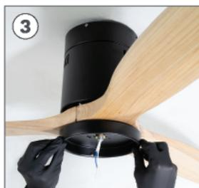
Pour placer la pièce H faites passer les câbles du ventilateur par le trou central, en faisant correspondre les 2 trous avec ceux du support central.
