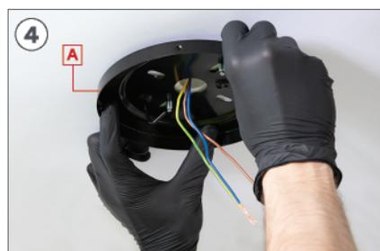
Placer la pièce **A** faire correspondre ses trous avec les vis **E**. Assurez-vous que les câbles de plafond passent à travers le trou central de la pièce **A**.
