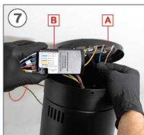
Connectez les fils de phase et neutre à la pièce **B**.
