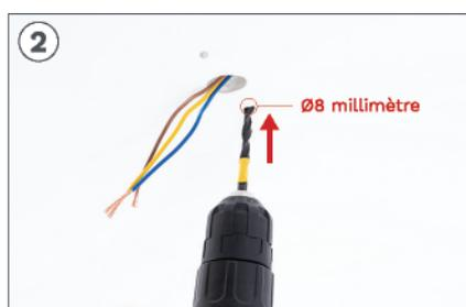
À l'aide d'une perceuse, percez les deux trous correspondants avec une mèche de Ø8 mm.
