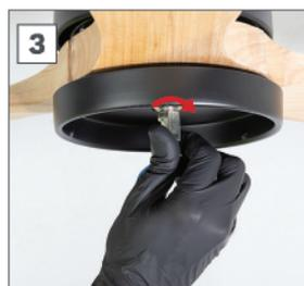
Faites passer soigneusement les câbles du ventilateur à l'intérieur de la pièce **Q** Oui les sortir à travers le grand trou latéral de la pièce. Puis visser la pièce **Q** et vérifiez que restes solidement fixé au ventilateur.
